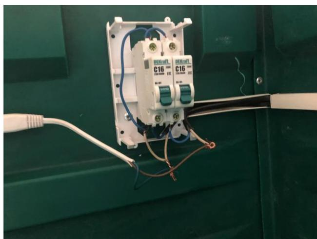
Изолируем провода и убираем их в короб. Закрываем короб автомата.
